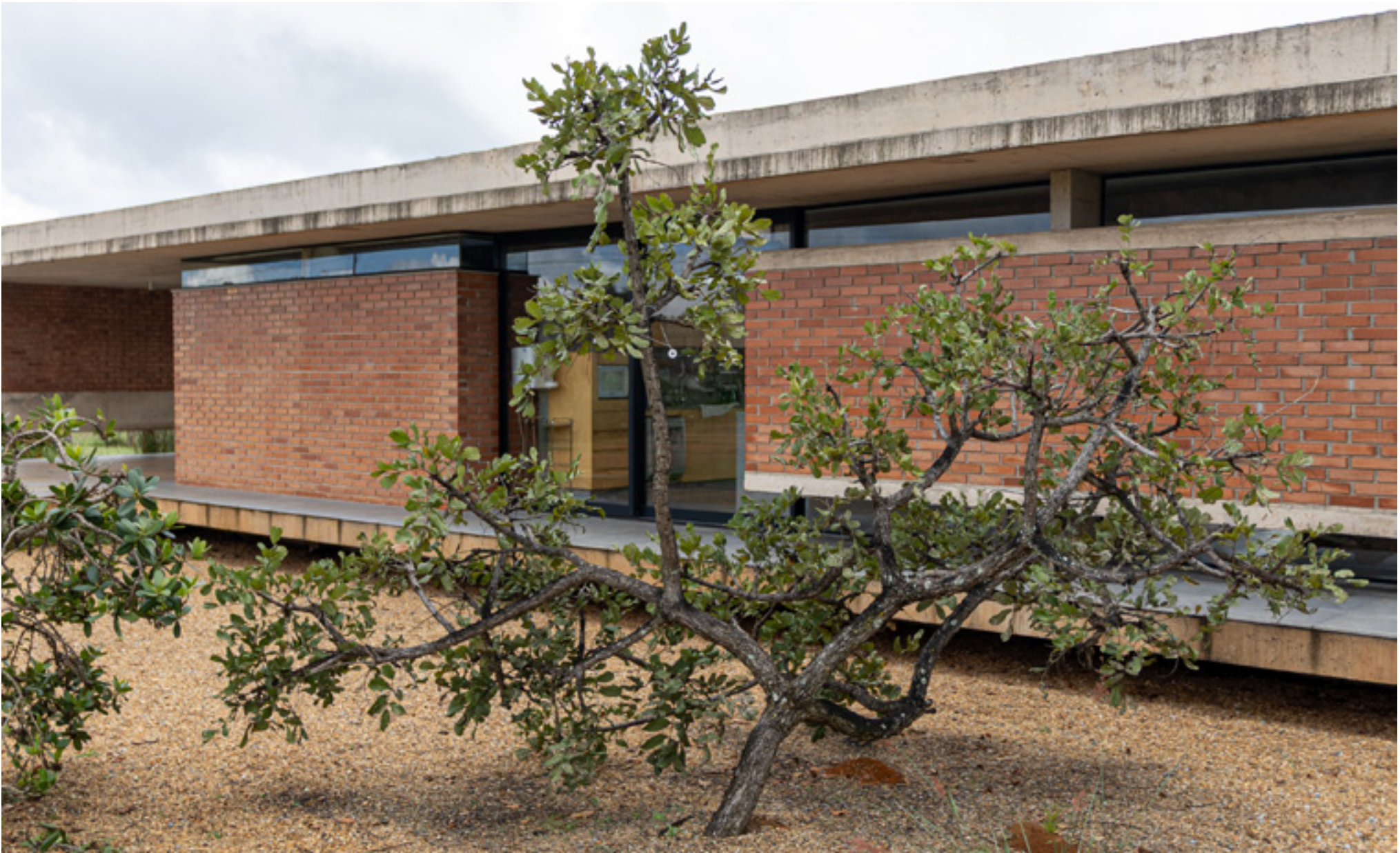
Andira fraxinifolia na Fachada Sul da Casa Vila Rica. Foto: Maurício Mercadante
